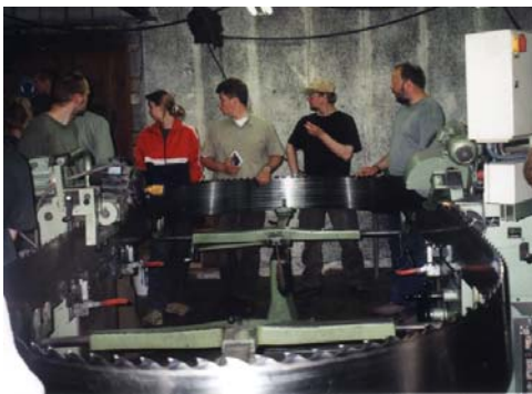
Schärfraum mit Einrichtungen zum Auftragen von Stellittropfen aus Hartlegierungen, zum Schleifen und zur Prüfung der Bombierung der Bandsägeblätter (zum Zwecke des ruhigen Laufes des Sägebandes auf den Rollen)
